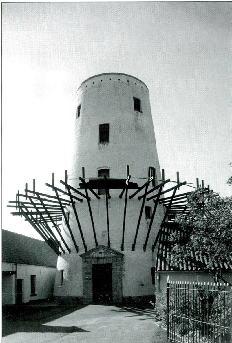
De nieuwe stelling van De Grote Macht in opbouw, april 2002. (Foto MR).
