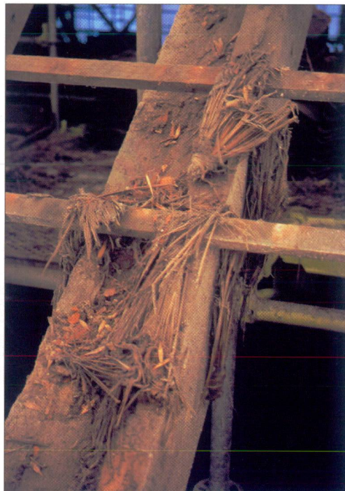
Lissewege, restauratie van de schuur van Ter Doest in 2001-2002. Van boven naar onder en van links naar rechts: de binnenzijde van de schuur is een woud van steigers (foto MR); detail van een van de gebinten (foto JC); dakspoor met restanten van stropoppen die als dichting tussen de pannen fungeerden (foto JC); de top van het dakgebinte op 16,50 meter hoogte (foto MR); het noordelijke gedeelte van de schuur gaat tijdens de werken schuil onder een plastic nooddak, dat later naar het zuidelijke gedeelte verplaatst zal worden (foto MR).
